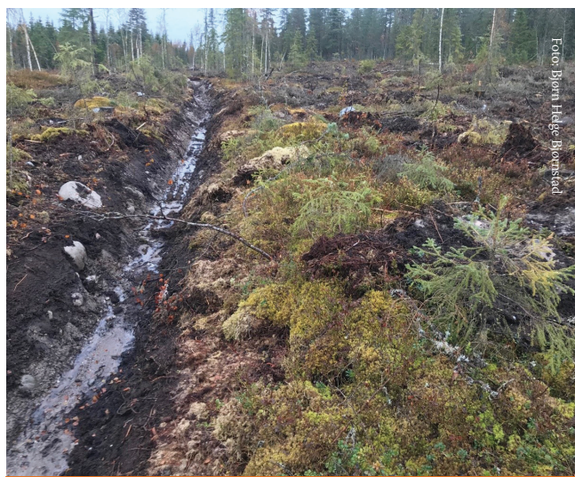
Grøfterensket av tidligere grøft. Grøftemassa er lagt ut i mindre hauger på begge sider av grøfta og fungerer som gode planteplasser.
