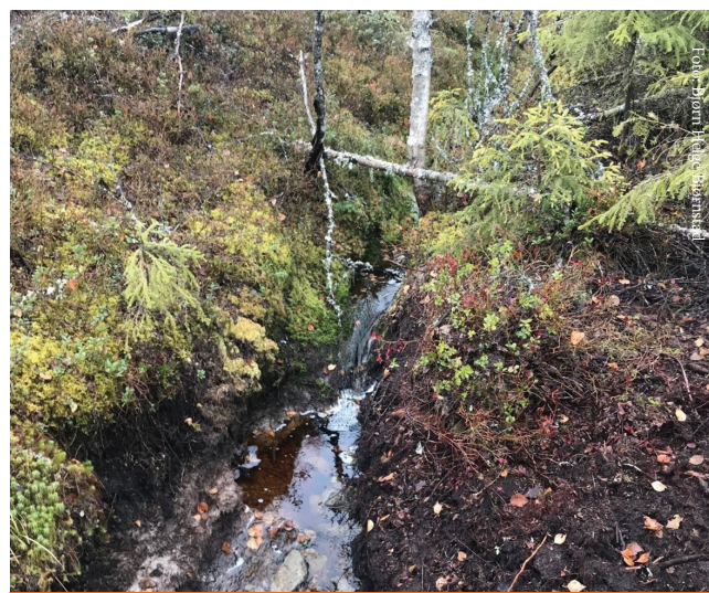
Del av grøft som ikke er rensket, dette for å redusere hastigheten på vannet i grøfta og unngå erosjon.
